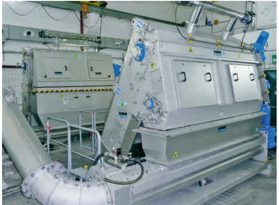
La ligne 1 vue depuis l'aval
