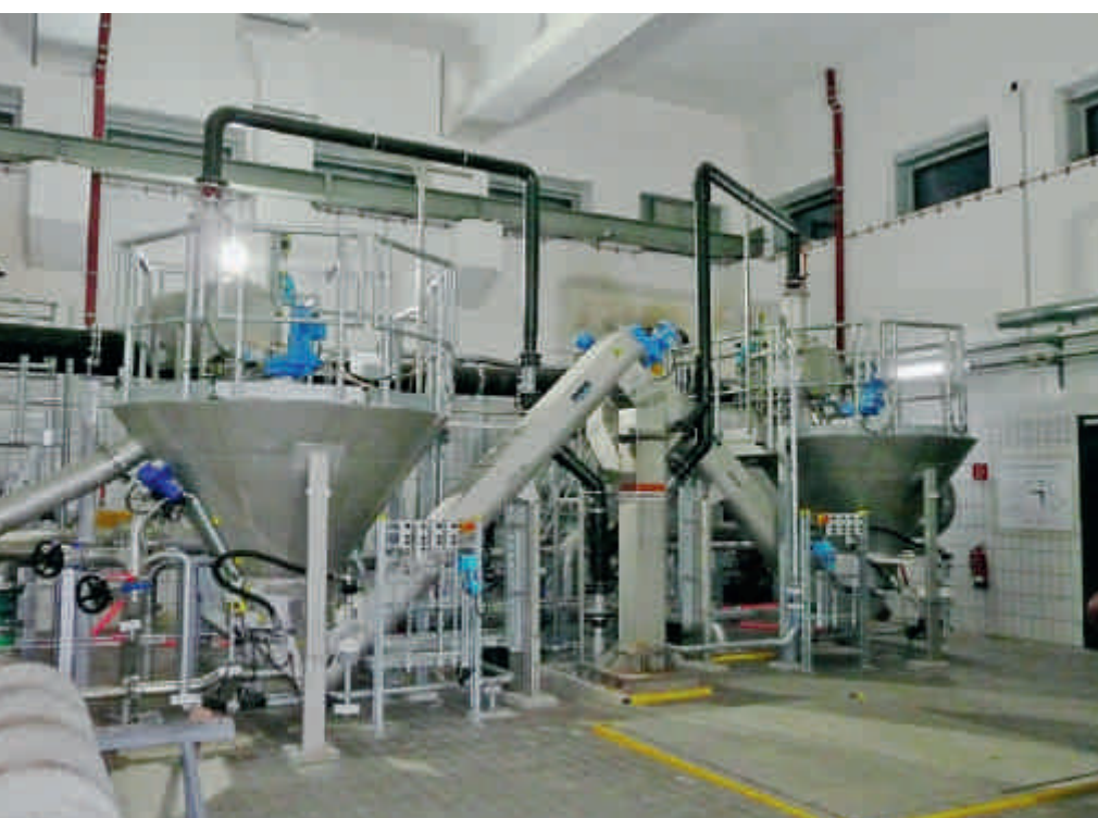
En service depuis 2011 – laveur de sable HUBER COANDA du type RoSF4 taille 16 l/s
