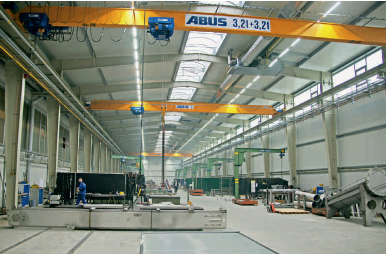
Vue d'ensemble du nouveau hall.
