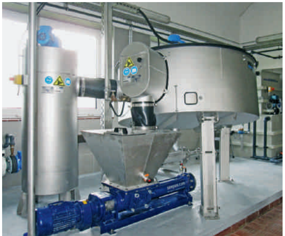
Épaisseurs à disque HUBER RoS2S – installation sur la STEP de Harlesiel
