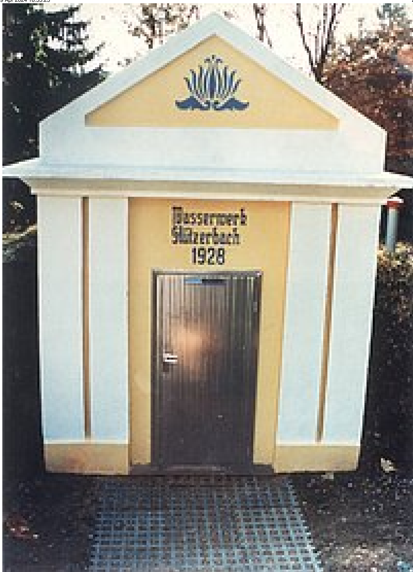
Einbruchhemmende Tür vor einem Trinkwasserspeicher
