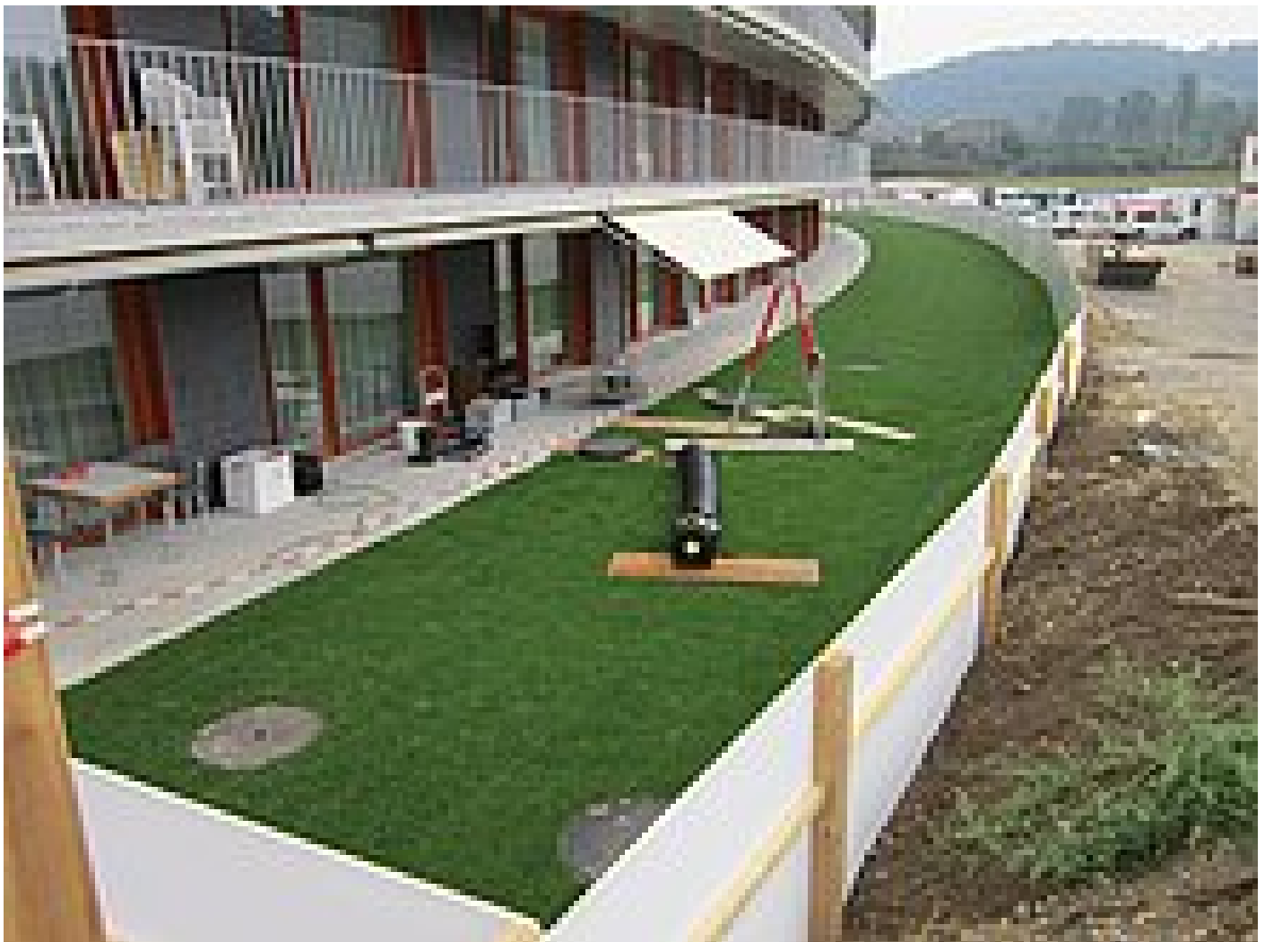
Abbildung 1: Altersheim Hofmatt in Münchenstein nach der Renovierung von Teilabschnitt 1. Im Garten zu sehen der Einstieg zum Abwasserschacht.
