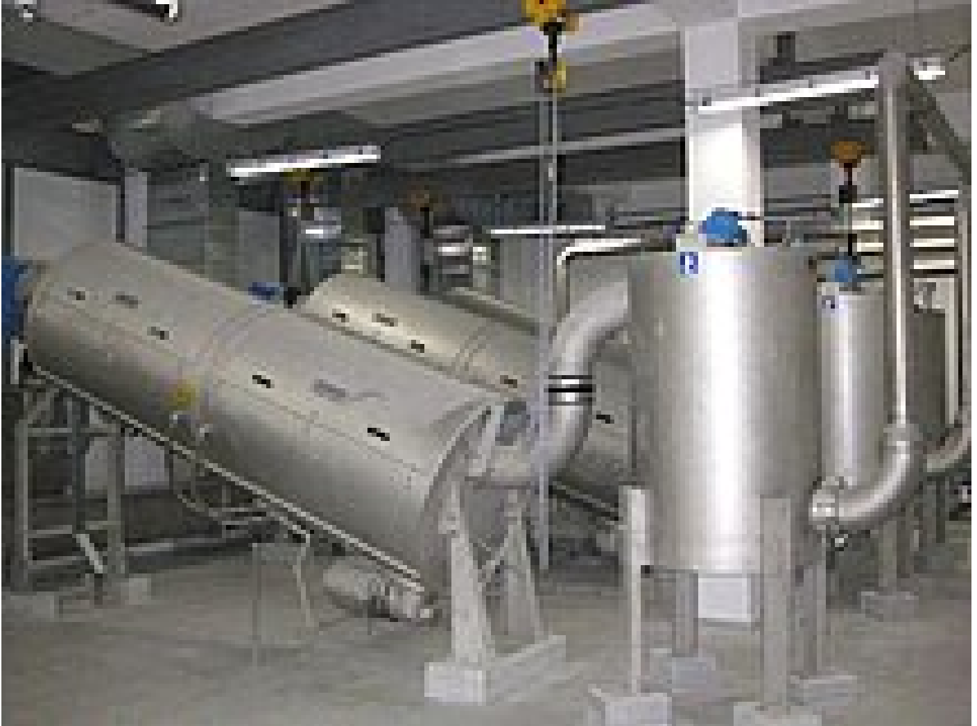
Drei ROTAMAT® Schneckeneindicker RoS 2 mit vorgeschalteten Flockungsreaktoren
