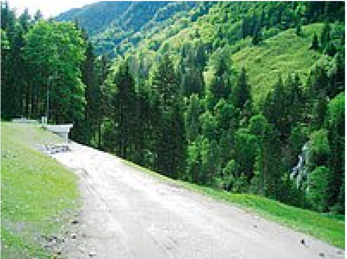
Das Einlaufbauwerk links und der Quell-Überlauf rechts
