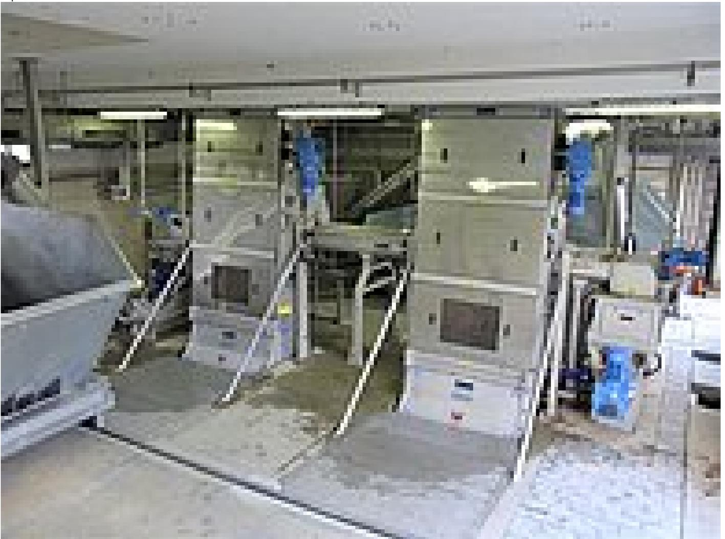
*Der HUBER Harken-Umlaufrechen RakeMax® HF mit der gekröpften Rahmenkonstruktion ist von außen fast nicht von der bewährten Basismaschine RakeMax® zu unterscheiden.*
