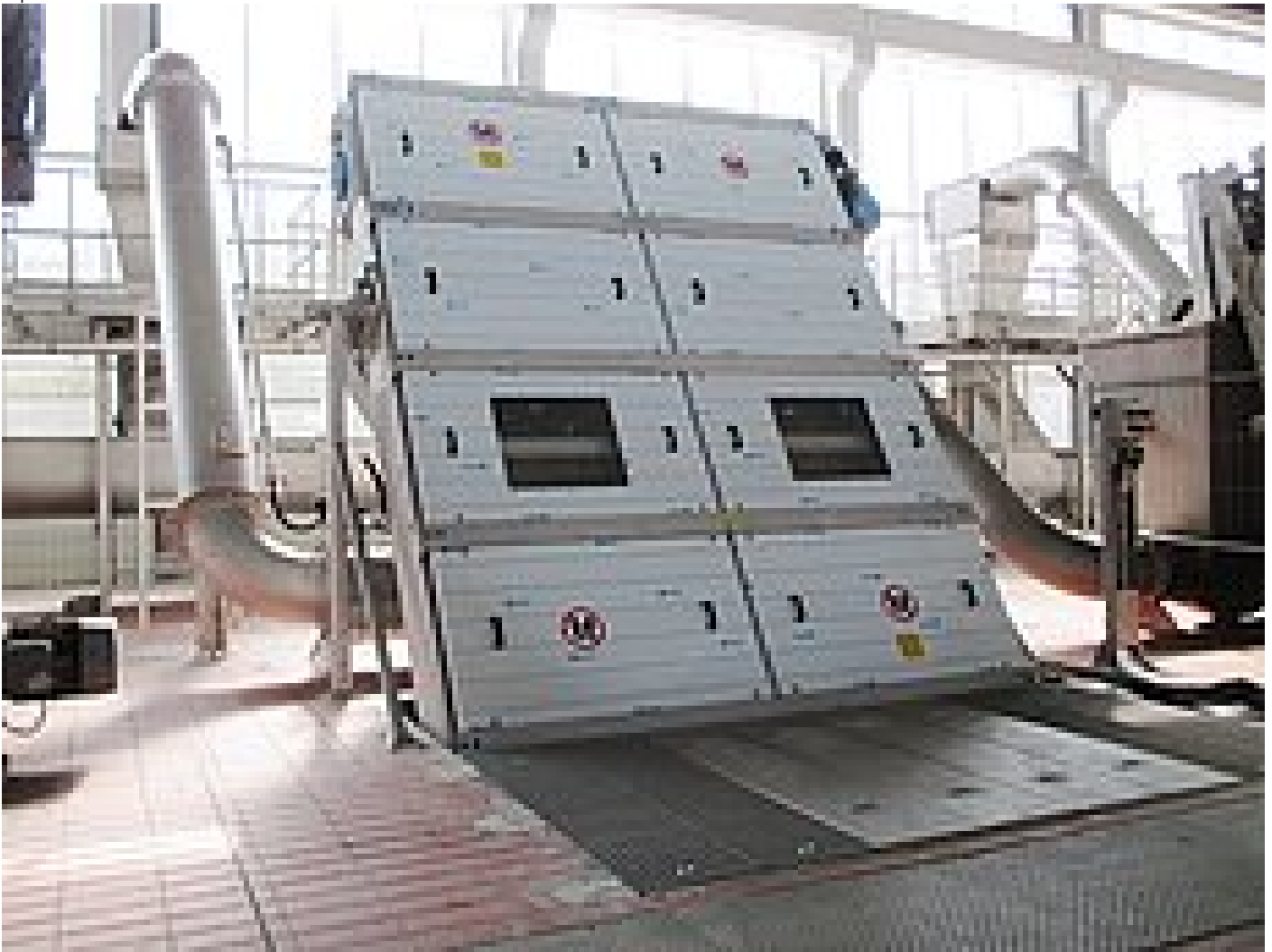
Einer der breiten HUBER Harken-Umlaufrechen RakeMax® als Grobrechen mit 8mm Spaltweite
