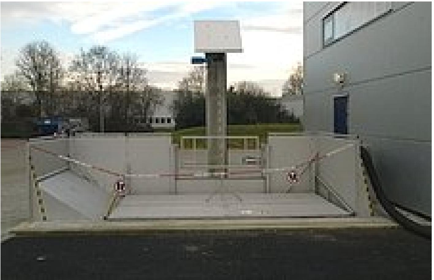
*Sandannahmeverfahren RoSF5 HW mit automatischer Abdeckung des Annahmebunkers an der Kläranlage Frankfurt Niederrad*
