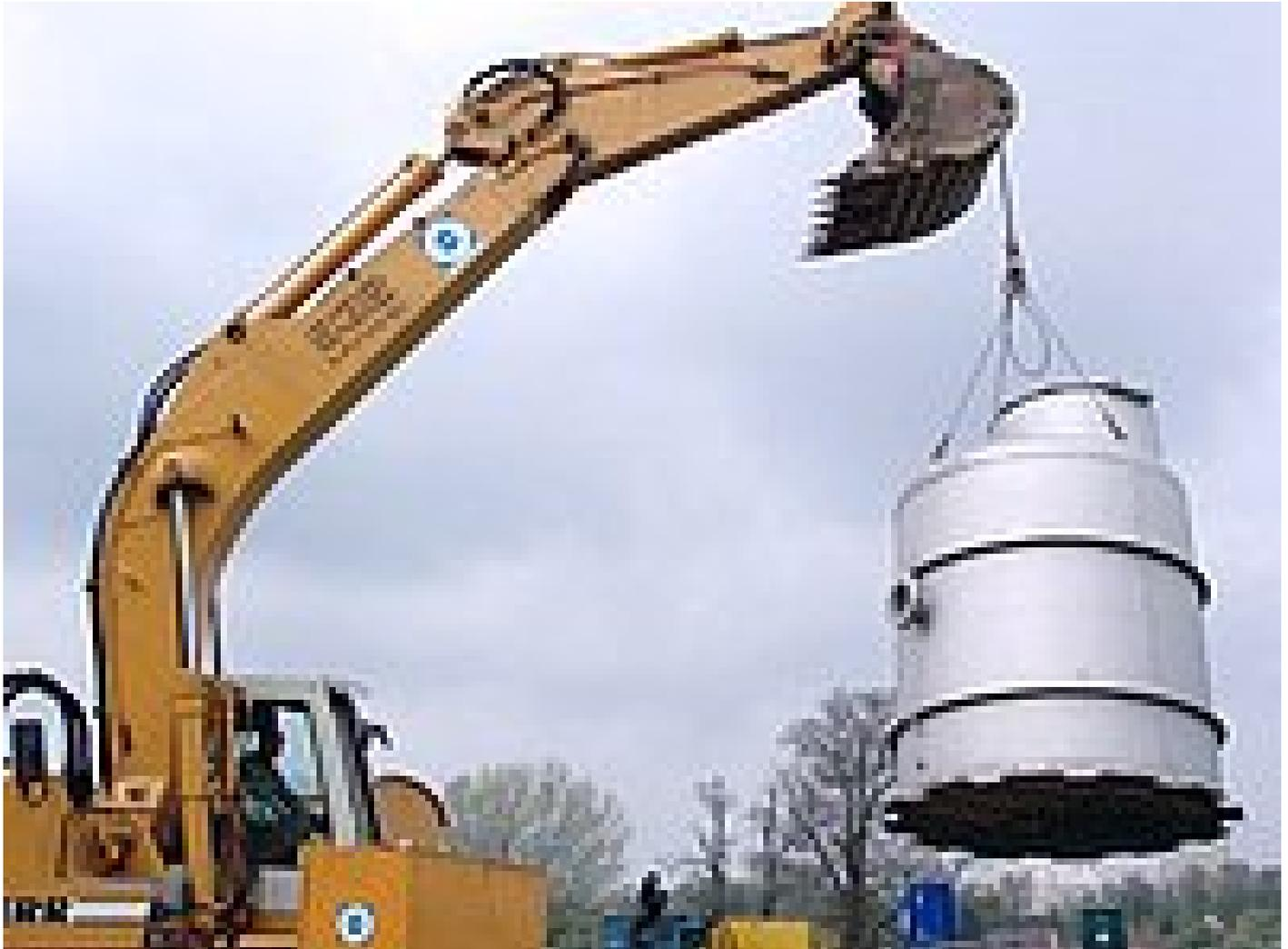
Fertigschacht, aus Edelstahl Werkstoff-Nr. 1.4307 (AISI 304 L), absolut wasserdicht, mit einer Einstiegs- und einer Montageöffnung gemäß DVGW Arbeitsblatt W 122.
