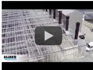
HUBER Schlammwender SOLSTICE®: Solare Klärschlamm-trocknung mit dem HUBER SRT-Verfahren https://www.youtube.com/watch?v=QdWwhrCOKug
