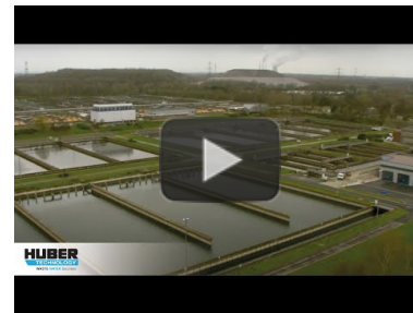
Video: HUBER Sandaufbereitungsverfahren RoSF5 - Kläranlage "Emschermündung" https://www.youtube.com/watch?v=GlnDTDmrBFE
