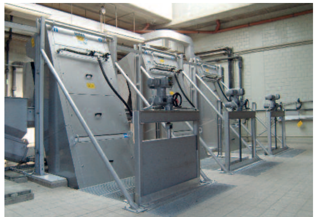
HUBER Stufenrechen STEP SCREEN® SSV: Länge 4300 mm, Spaltweite 3 mm, aus Edelstahl gefertigt und im Vollbad gebeizt für einen optimalen Korrosionsschutz.
