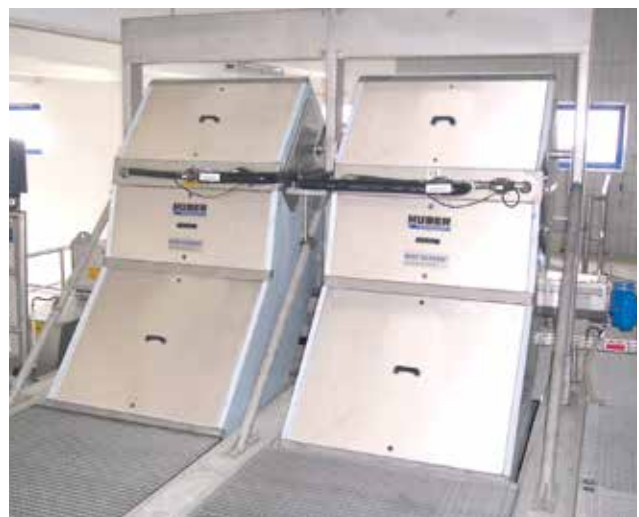
Zwei HUBER Stufenrechen STEP SCREEN® SSF in parallelen Gerinnen.
