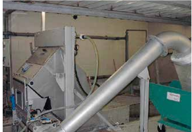
HUBER Stufenrechen STEP SCREEN® SSF mit HUBER Waschpresse WAP® für optimale Abscheide- und Entwässerungsleistungen. Zum Korrosionsschutz aus Edelstahl gefertigt und im Vollbad gebeizt.
