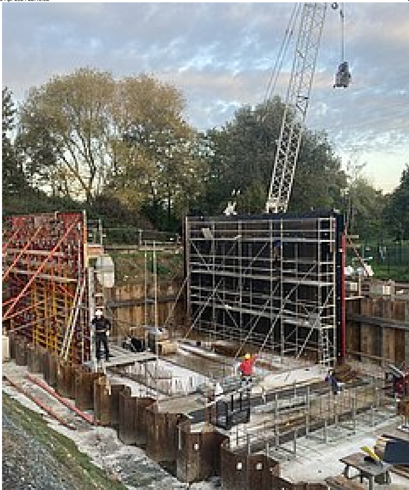
La costruzione della struttura per lo stadio di filtraggio a carboni attivi a Bickenbach sta procedendo. (Foto: Jörg Stanzel, Abwasserverband Bickenbach)
