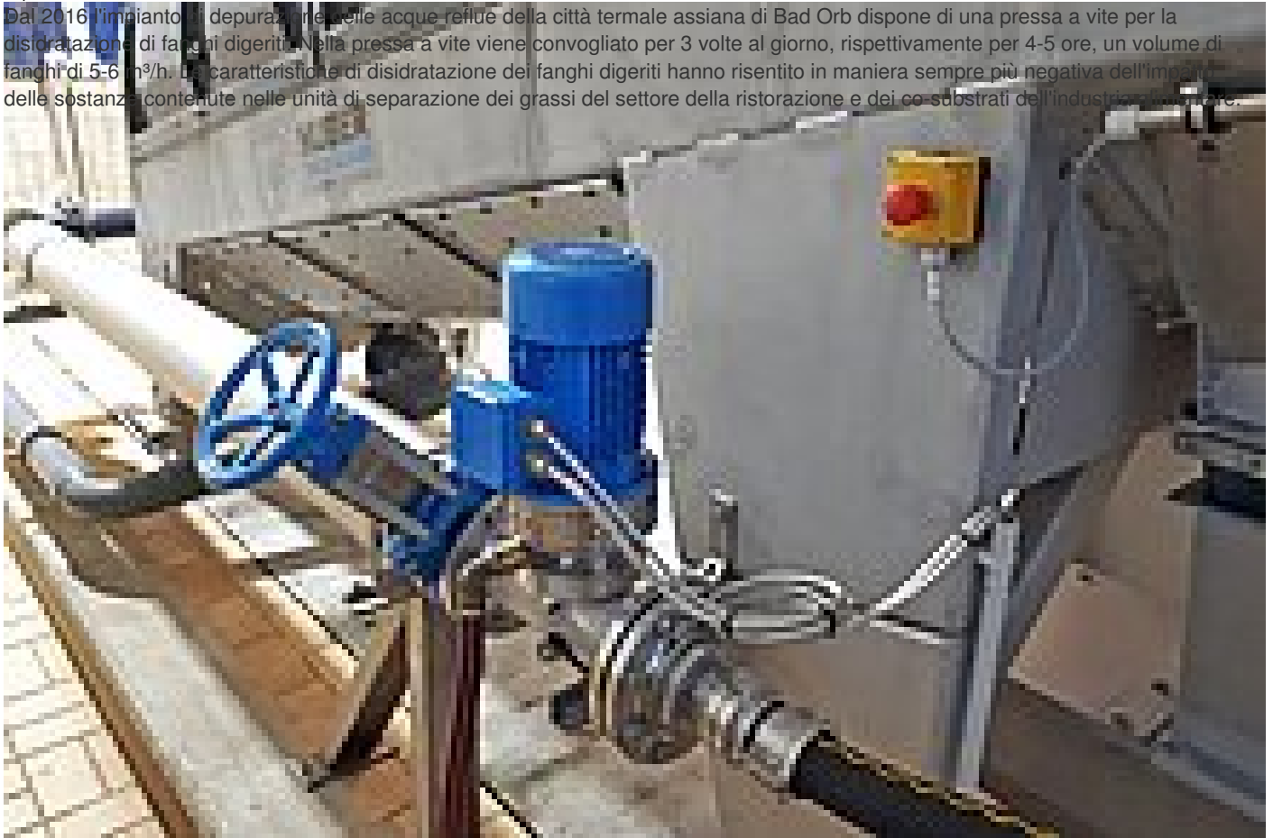
Il miscelatore di polimero in linea IPM 100 di HUBER a monte di una pressa a vite
