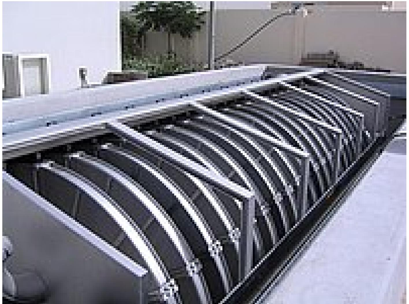
Filtro a dischi per la microseparazione dei solidi sospesi prima dell'immissione nel corpo ricettore
